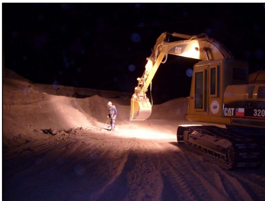
Máquina de Desminado Sifting Excavator trabajo de despeje en Quebrada Escritos, Región de Arica y Parinacota
