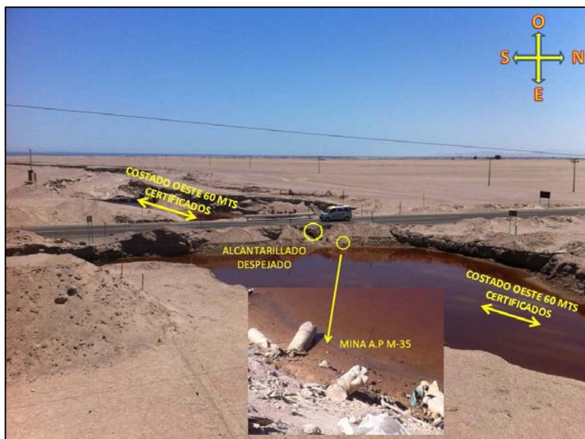
Sector libre de minas lado oeste quebrada de Escritos, certificado en DIC.2010 colapsado de agua
