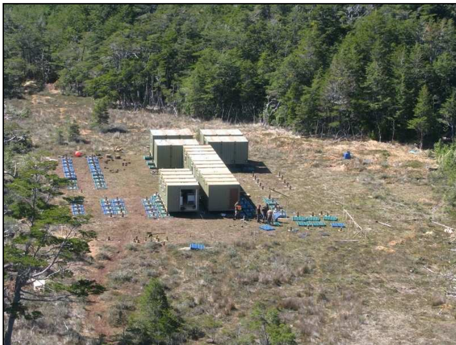
Instalación de Campamento POMTA en Isla Picton,
